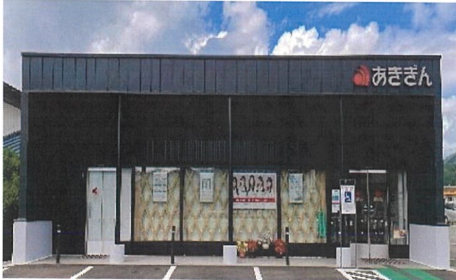
外観（正面全景）
